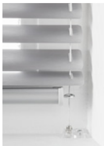
Spandraad in het kozijn
