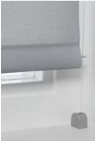
Spandraad in het kozijn
