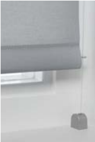
Spandraad in het kozijn
