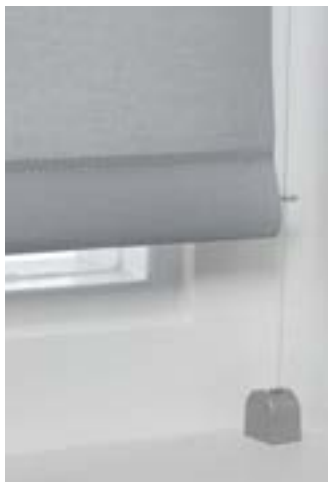
Fils tendeurs dans le cadre de fenêtre
